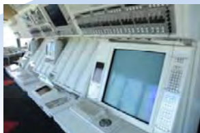
各種コントロールユニット 放送機器/通信基地局機器
